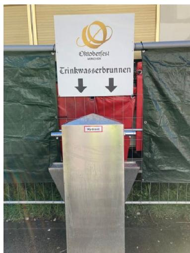
Die doppelte Zapfstelle wurde in Form eines Kastens auf den Feuerwehrhydranten gesetzt. Der Trinkwasseranschluss erfolgt direkt aus dem Hydranten. Der Wasserablauf wurde auf die Straße geleitet. Im Umfeld der Trinkwasserabgabestelle kam es hier zu leichten Überschwemmungen, insbesondere im Bereich der rückwärtigen Schaustellerbereiche.
