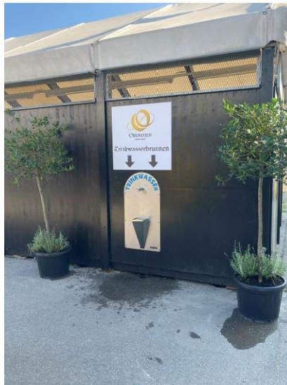
Die Trinkwasserabgabestelle wurde an die Holzaußenwand der Toilettenanlage angeschlossen. Der Trinkwasseranschluss erfolgt ebenfalls aus der Frischwasserleitung der Toilettenanlage. Der Wasserablauf wurde direkt an die Kanalisation angeschlossen.
