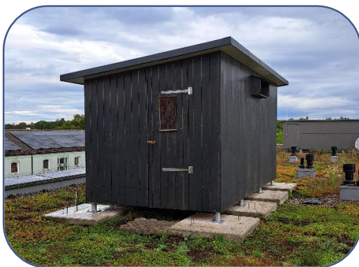
Taubenhaus auf einem Flachdach
