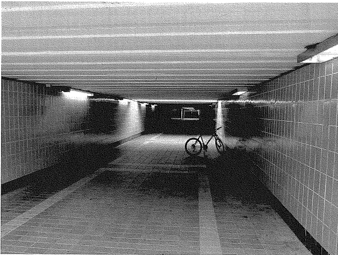
Blick in die Unterführung von Osten kommend. Deutlich sichtbar ist der breitere Bereich der Unterführung.
