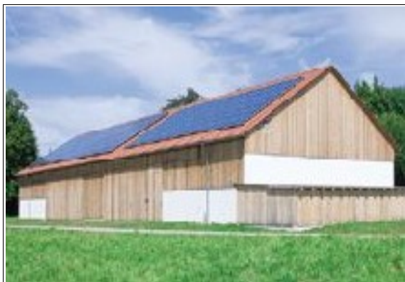
Abbildung 9: PV-Anlage auf dem Gut Großlappen (Photo: Kommunalreferat München)
