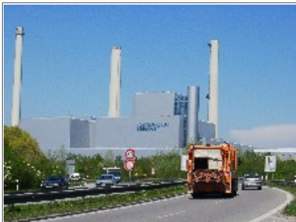
Abbildung 6: HKW München - Nord (Unterföhring) (Photo: Kommunalreferat München)
