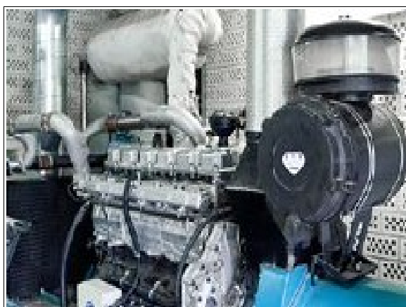
Abbildung 8: Blockheizkraftwerk Gut Karlshof (Photo: Kommunalreferat München)
