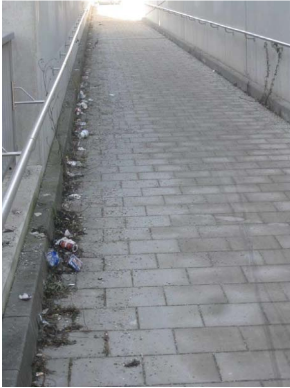
Freiham Bahnhof Südseite
