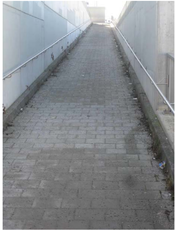
Freiham Bahnhof Nordseite
