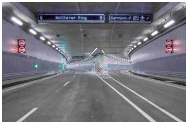
Nach rund sechsjähriger Bauzeit ist der Luise-Kiesselbach-Tunnel seit dem 25. Juli 2016 für den Verkehr geöffnet. Quelle: Jens Weber, München
