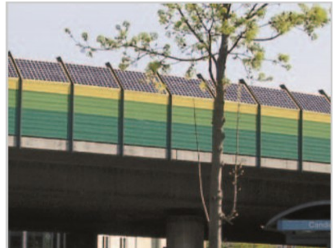
Bild: Solaranlage auf der Lärmschutzwand Candidstraße aus dem Folder „Ausbau städtischer Solaranlagen“ © Baureferat und Umweltreferat, 2004
