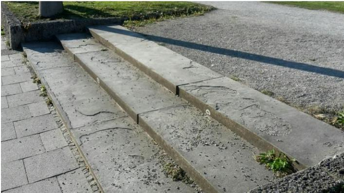
Abb. 5: Treppenanlage Gabelsbergerstraße zum Areal AP mit diversen Abplatzungen auf den Stufen
