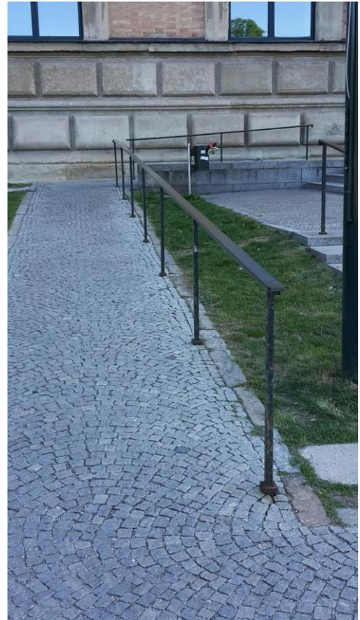
Abb. 6: Stark rostige Geländerstützen an der Rampenanlage zum Haupteingang AP
