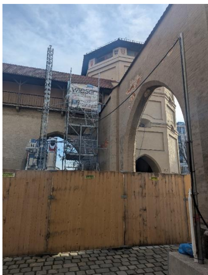
Ansicht mit Bauzaun mit Blick auf die Ostseite des Isartors
