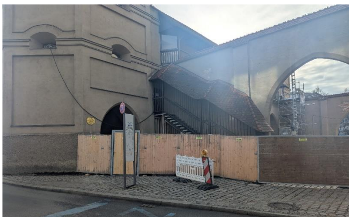
Ansicht mit Bauzaun auf der Nordseite des Isartors
