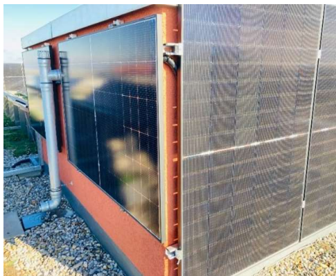
Abbildung 34: Fassaden-Module im Projekt Karl-Marx-Ring 11-21
