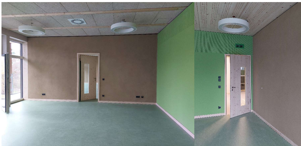
Abbildung 38: Trockenbauwand mit Bekleidung aus Lehmbauplatten im Haus für Kinder in der Quiddestraße
