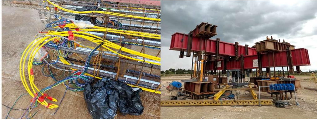
Abbildung 37: Li: Messtechnik im Probepfahl Re: Aufbau der Belastungseinrichtung
