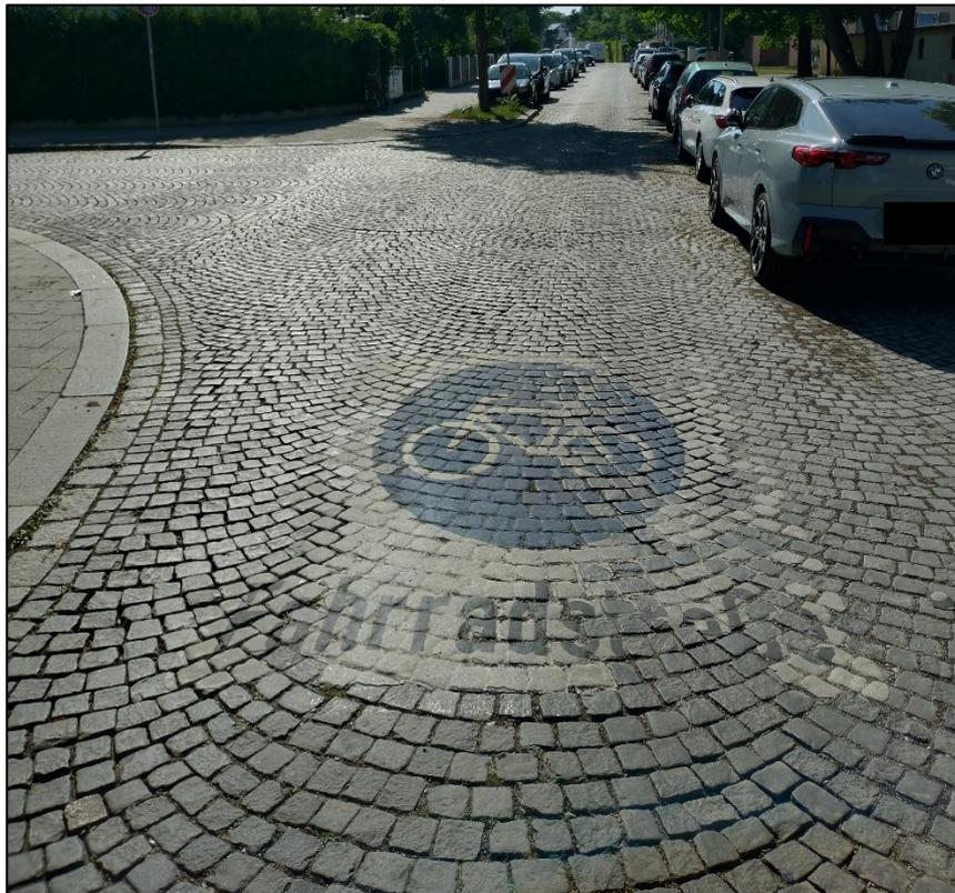
**Abbildung 4:** Welzenbachstr. Kreuzung Templestr., Blickrichtung West., mit erodiertem Piktogramm auf der Fahrbahn (Bild: K. Schacht, 30.6.2025)
