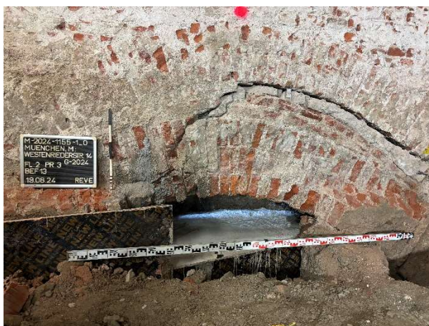
Abb. 15: Mächtige Entlastungsbögen ermöglichten im 19. Jahrhundert das Bauen auf unsicherem Untergrund. Abb. 16: Reste der Vorgängerbebauung aus dem 19. Jahrhundert unter dem Kellerfußboden.
