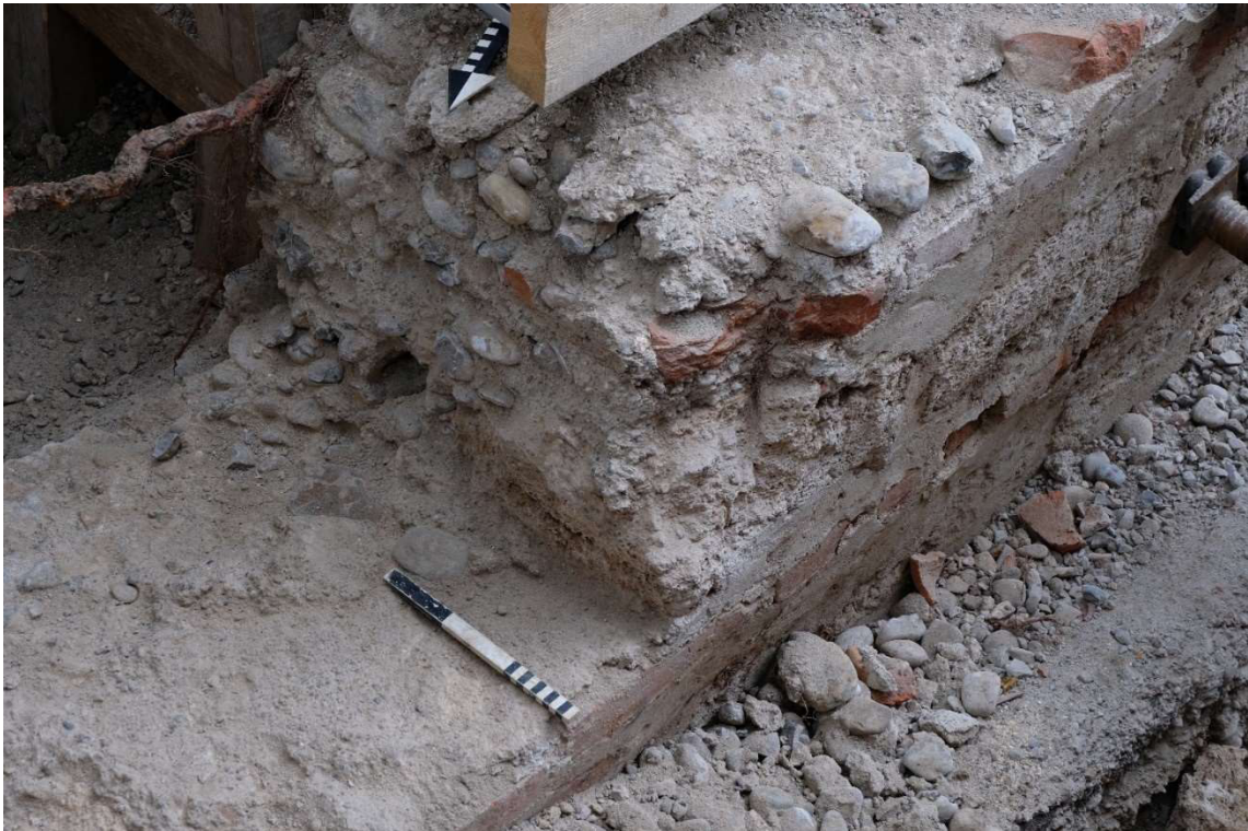
Abb. 13: Mauerzug mit typischer Mauertechnik aus Ziegelsteinen und Bachkieseln. Hier die verputzte Innenseite, ehemals zu einem Keller gehörig.
