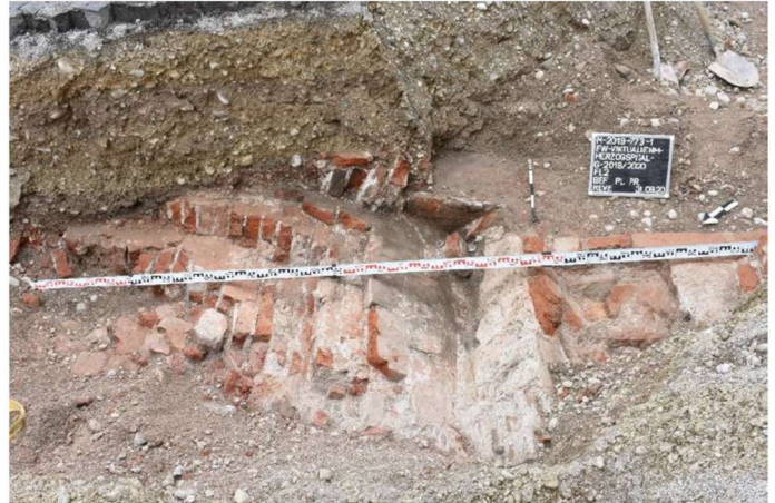
Abb. 17: Freigelegter Bogen der ehemaligen Brücke vor dem Sendlinger Tor. Links: Ansicht des Sendlinger Tores mit Brücke 1812. Historischer Verein von Oberbayern Bildersammlung, Stadtarchiv München DE1992-HV-BS-B-01-41, Domenico Quaglio: Sammlung merkwürdiger Ansichten in Baiern und dessen Hauptstadt in zwölf radirten Blättern, München 1811/12.
