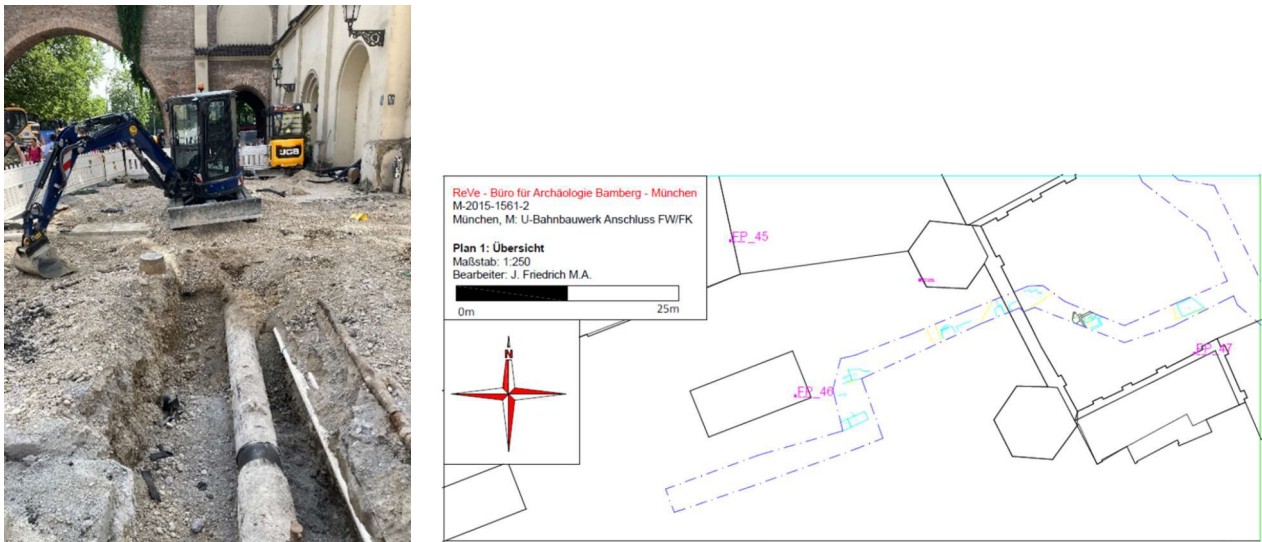
Abb. 15: Arbeiten zur Fernkälte, begleitet durch eine archäologische Fachfirma.
