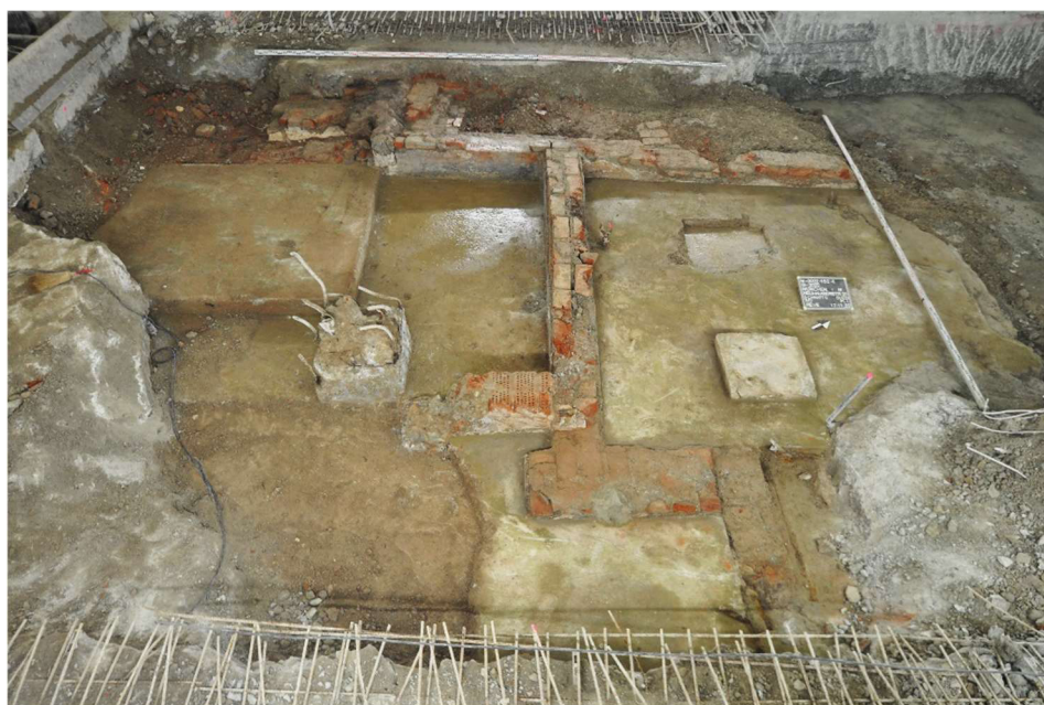
Abb. 6: Reste älterer Bebauung von vor 1945. Im Bildrand zu sehen die Bewehrungsanschlüsse der neuen Bodenplatte.
