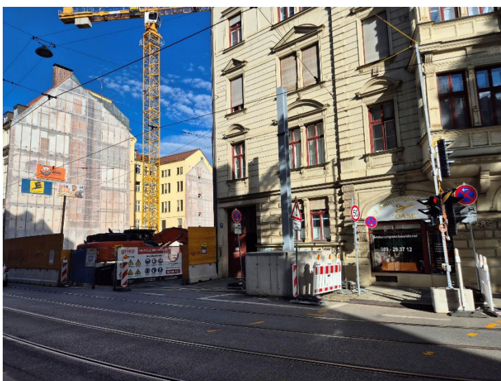
Baustelle mit eingerichteter Ampel sowie Baustelleneinrichtung an der Thierschstraße
