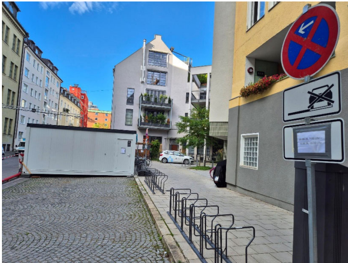
Baustelleneinrichtung Liebherrstraße vor dem neuen Gebäude der München Wohnen
