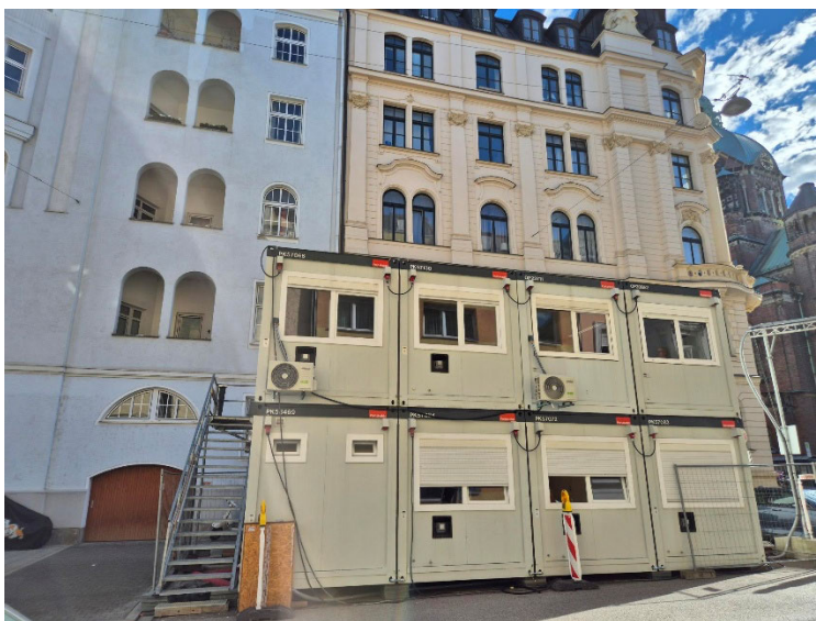
Baustelleneinrichtung Adelgundenstraße / Thierschstraße
