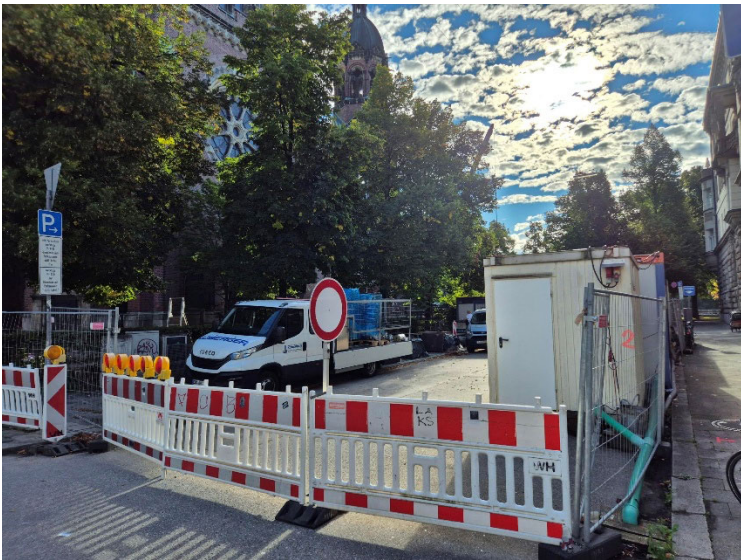
Baustelleneinrichtung der Baustelle Lukaskirche am südlichen Mariannenplatz
