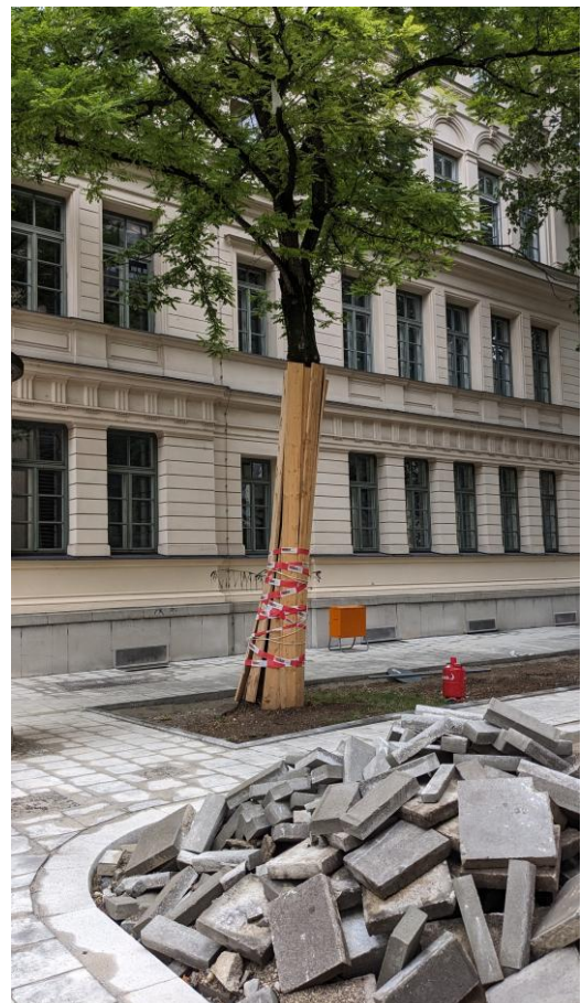
Stammschutz in verbesserungsfähiger Ausführung an einer Platane in der Wallstraße. Öffentliche Baumaßnahme um den neuen U-Bahnzugang. Aufnahme vom 17.07.2025 (Foto: Baumschutzbehörde).
