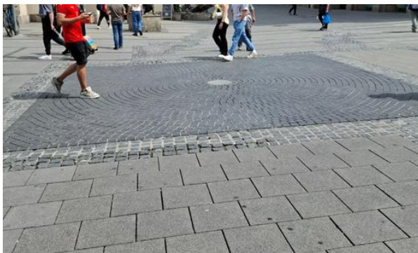
Abbildungen: Abzweigungen aus Kleinstein und Mosaikpflaster (links Höhe Neuhauser Straße Hausnr. 1 / rechts Höhe Kaufinger Straße Hausnr. 28) Quelle: Mitarbeiterin des Baureferats, 2025
