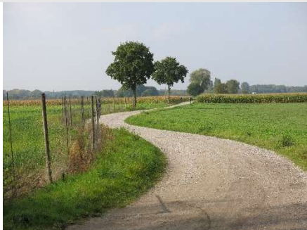
Weg in der Nähe des Würmkanals Foto: Matthias Lampert /LHM
