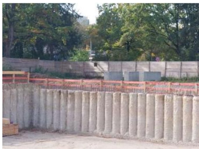
Abbildung 17: Verwendung von RC-Beton mit vollständig rezyklierter Gesteinskörnung für Bohrpfähle im Projekt Campus Ost (Fotografie Baureferat)
