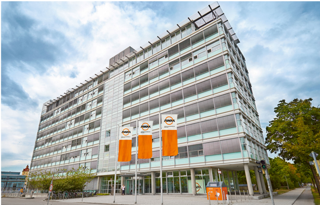
Abbildung: Verwaltungsgebäude des AWM am Georg-Brauchle-Ring 29
