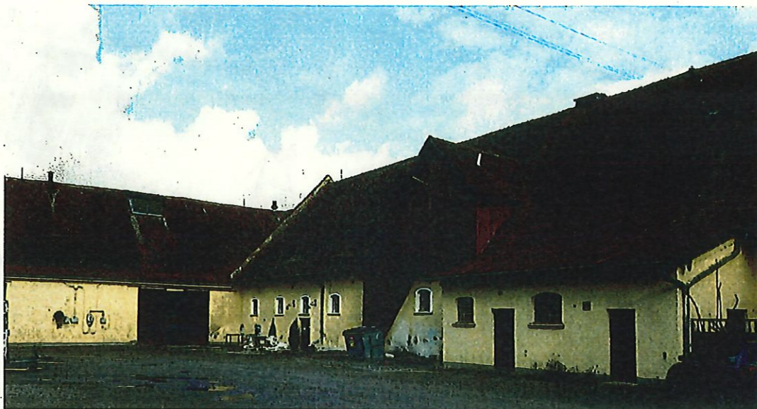
Abb. 09 Ehem. Kuhstall (D-1-62-000-1869) mit winkelförmigem Grundriss zur Allee orientiert, errichtet Ende des 18. Jh, nach Brand 1913 wieder aufgebaut
