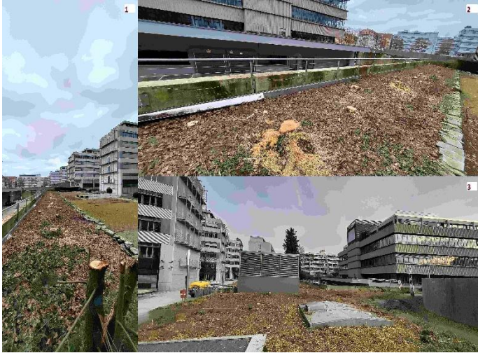
Foto 3: rechts VKB Büro Deisenhofener Str. 75, daneben Plateau
