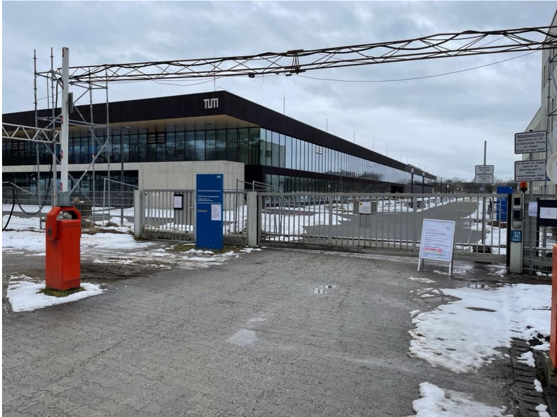
Blick früherer Eingang, jetzt gesperrt und links der Beginn der Rampe zum neuen Eingang. Foto: privat
