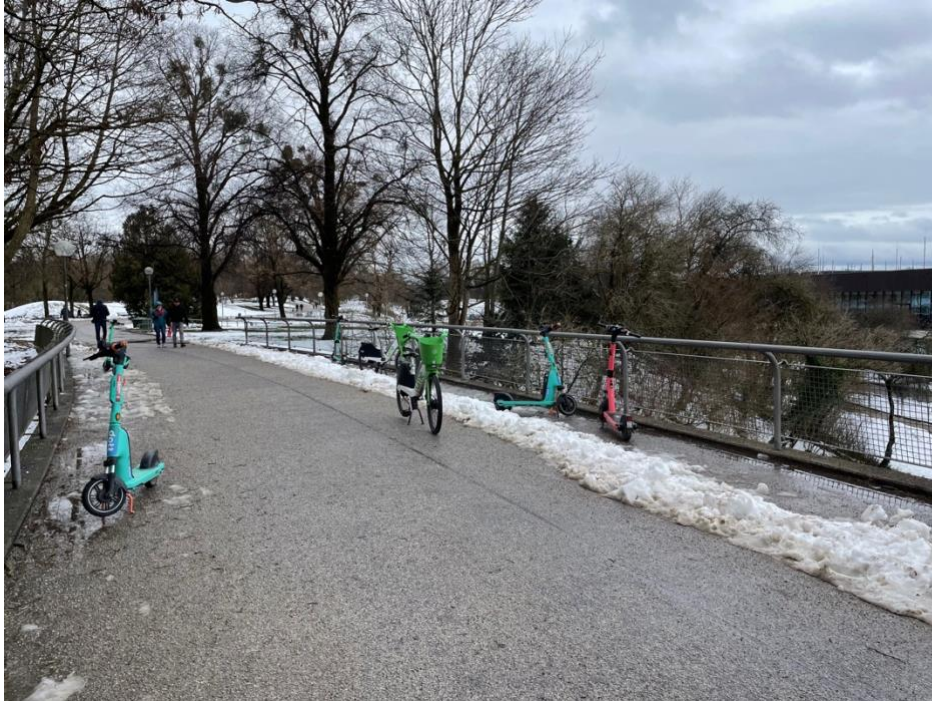
Selbst bei Schnee unzulässiges Abstellen oben auf der Brücke. Foto: privat
