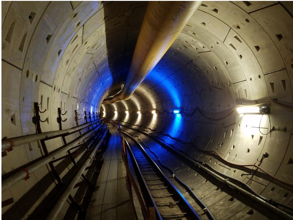
Abbildung 65: Tunnelröhre mit Tübbingausbau
