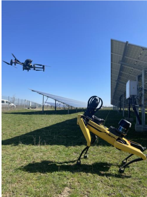
Abbildung 13: Erprobung von Robotik in PV-Anlagen
