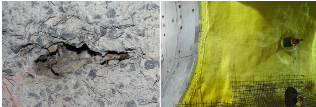
Abbildung 67: Spritzmembranabdichtung im Querschlag
