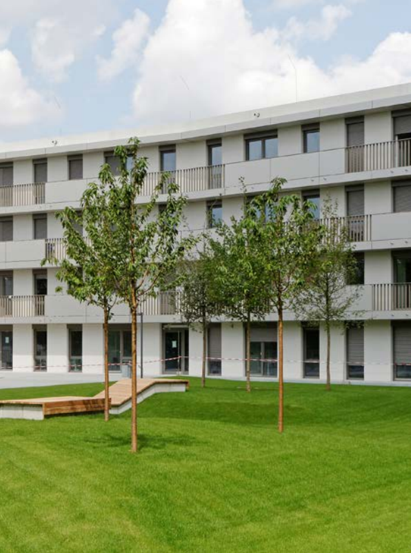
Bild oben: Der Dachgarten ist ein Teil der Lärmschutzbebauung Ecke Innsbrucker Ring/Grafinger Straße. Er befindet sich über einem Supermarkt.
