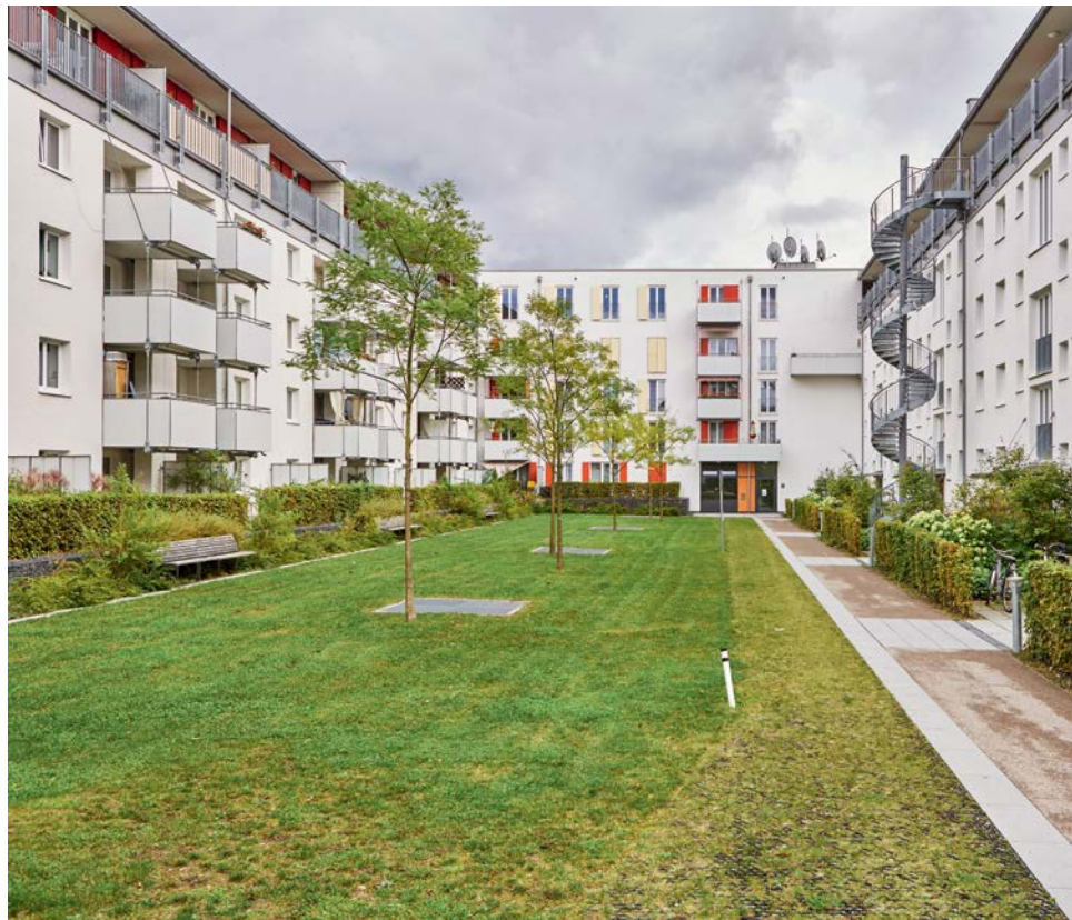
Bild rechts: Blick in den Innenhof der Lärmschutzbebauung Zornedinger Straße von Felix+Jonas Architekten mit Lückenschluss zur Nachbarbebauung
