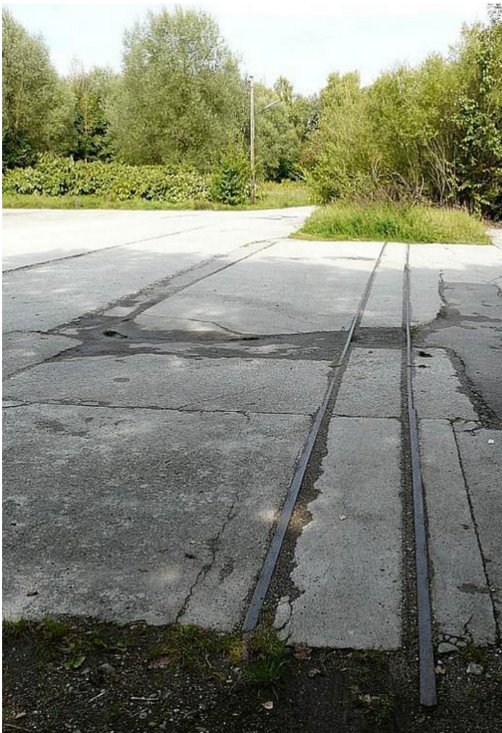
Blick auf die Gleise auf dem Parkplatz von Süden her
