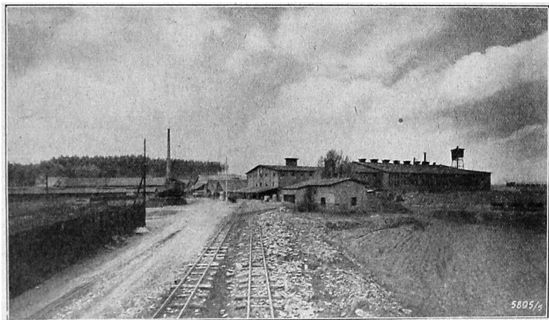
Historische Aufnahme der Ziegelei Lochhausen von 1927, Blick von Nord nach Süd.
